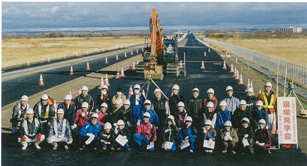
平成27年11月9日 釧路外環状線北園西改良工事 現場見学会
